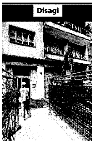
I lavori in via Foppa.
