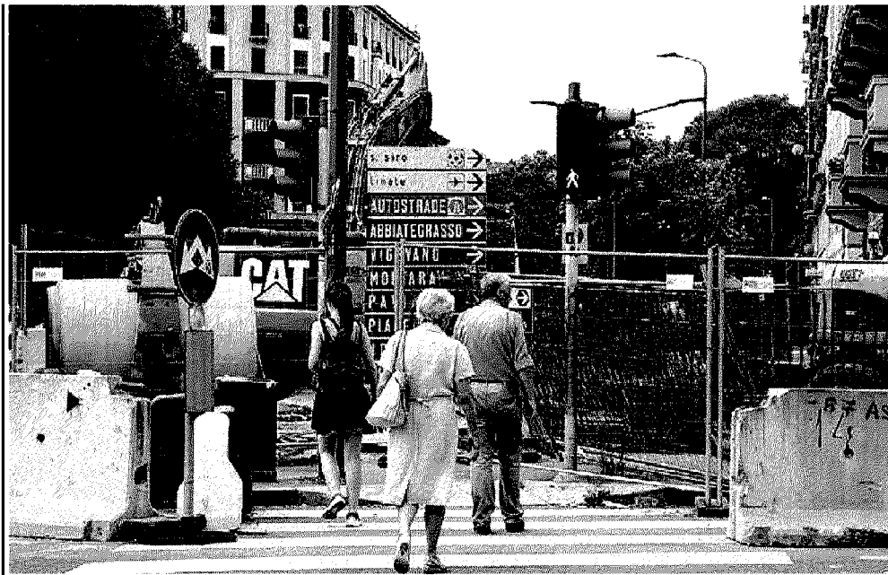
Cantiere metro M4 in via Vincenzo Foppa [Ftg]
