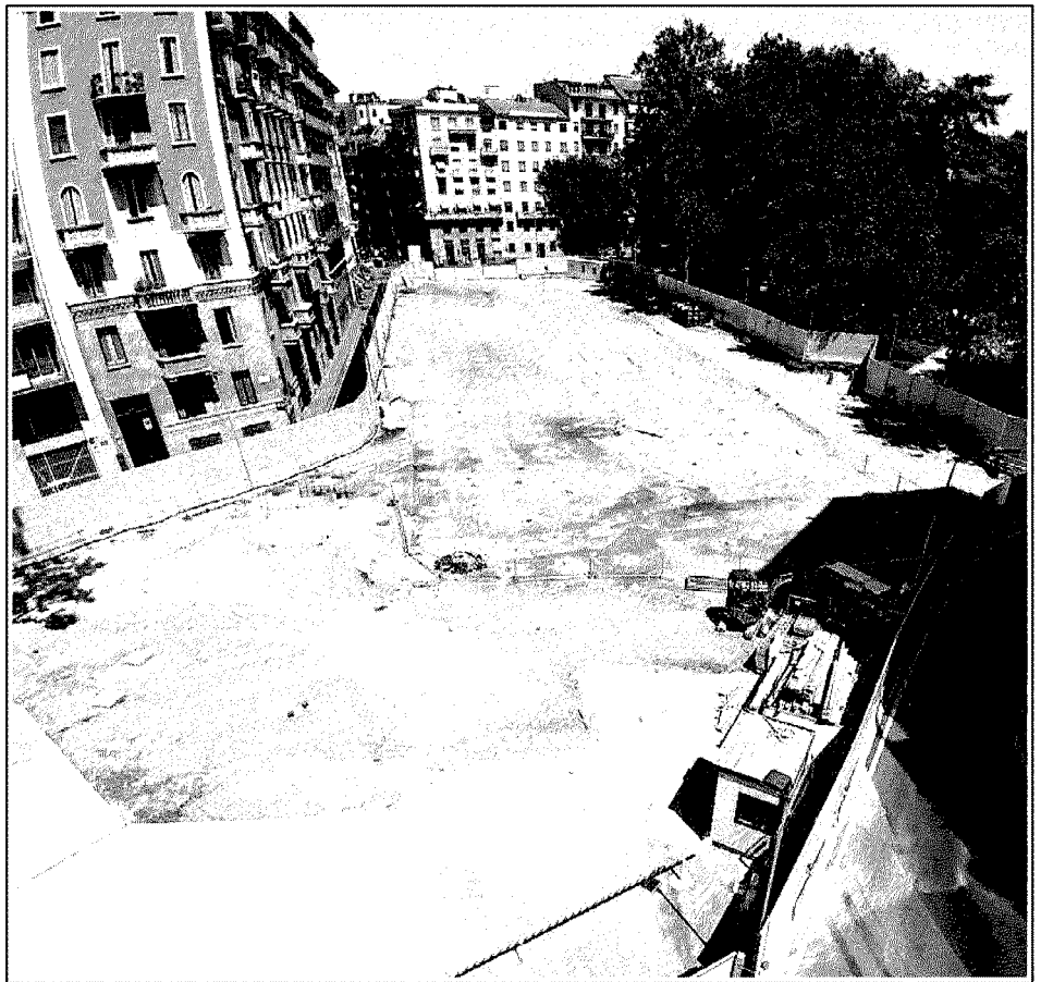
Visuale dall'alto del cantiere M4 Foppa-Solari [Ftg]
