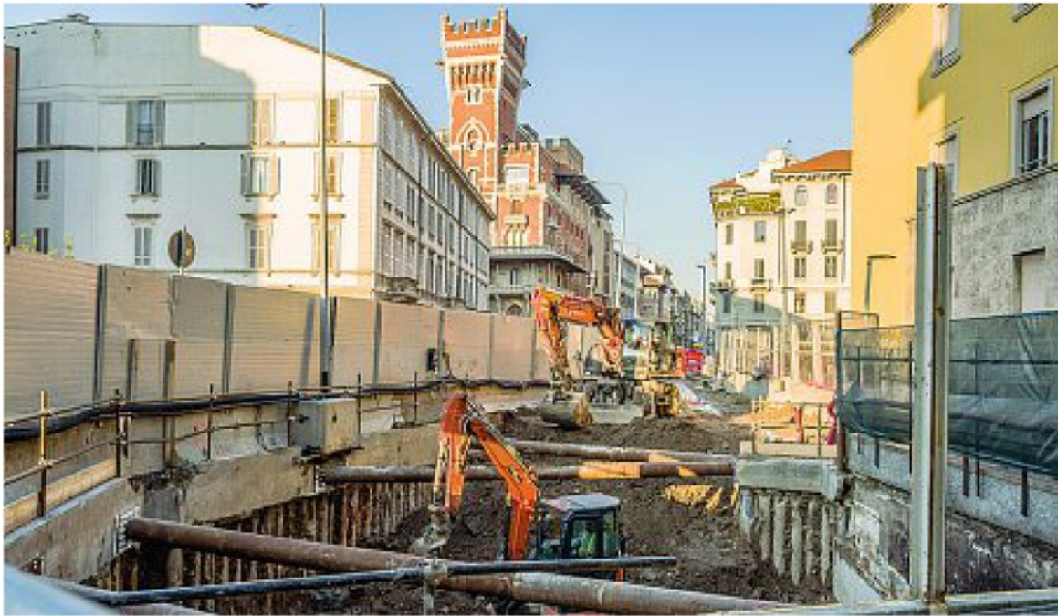
Gli scavi tra via De Amicis e via Carducci in Sant'Ambrogio. Il muro medievale è stato trovato verso piazza della Resistenza Partigiana (Cozzoli/Ansa)
