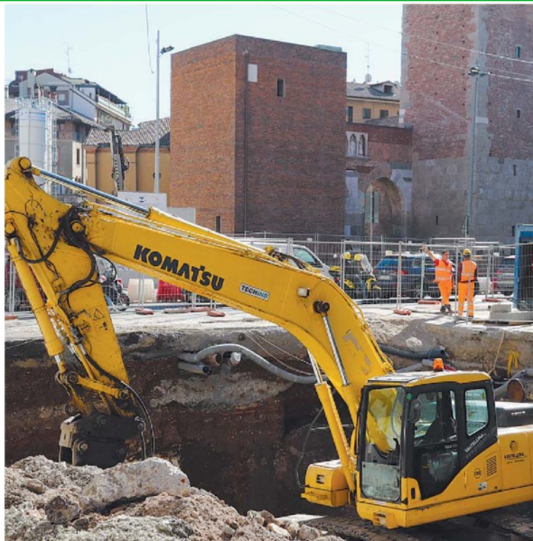
La ruspa in piazza Sant'Ambrogio per i lavori della M4
