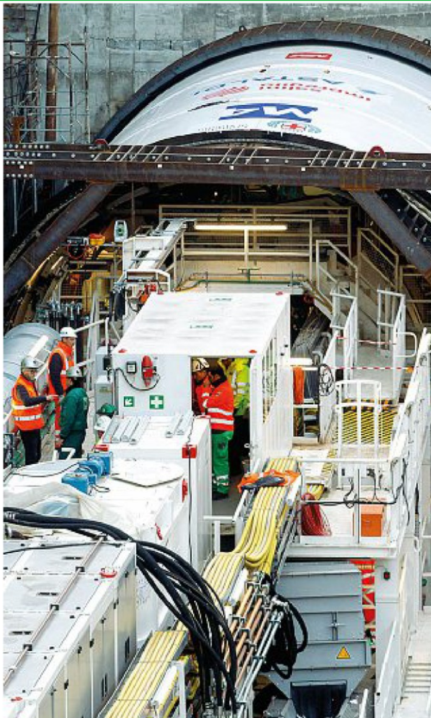
Operativa A 20 metri di profondità, la tunnel boring machine assemblata in Germania arriva nel cuore della città dopo aver finito di scavare i primi 8 chilometri del tracciato da Linate a piazza Tricolore
